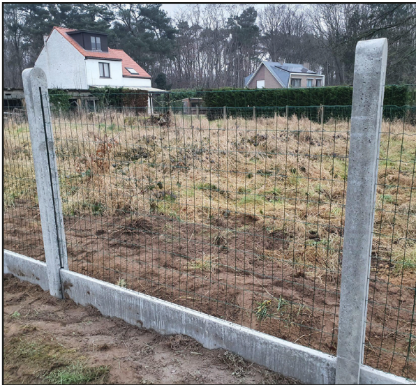
Gelaste draad in combinatie met betonpalen Kleur zwart, hoogte 150cm.
