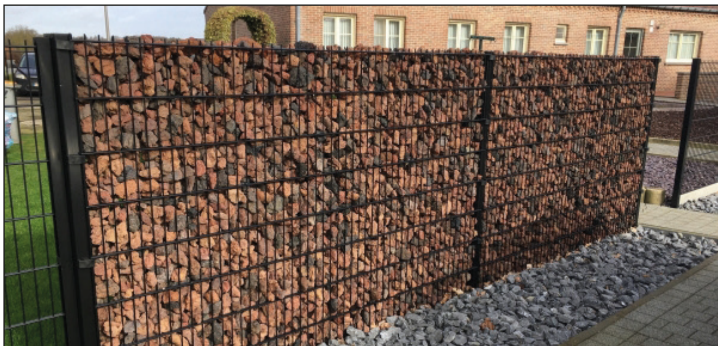
Steenkorf uit zwart draadpaneel met lava stenen gevuld. Hoogte: 160cm
