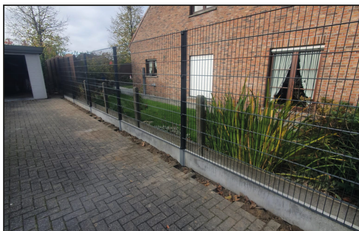
2D panelen met betonplaat bevestigd aan vierkante palen. Kleur: Zwart, Hoogte: 203cm
